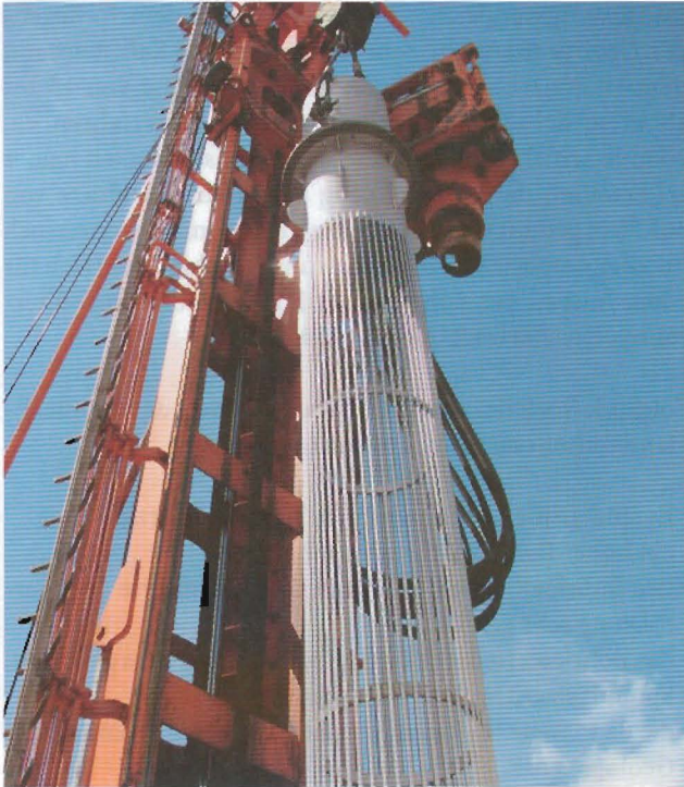
Abb. 4 Der Stabfilter wurde zusammen mit einer Edelstahlrohrtour als Endverrohrung eingebaut.
