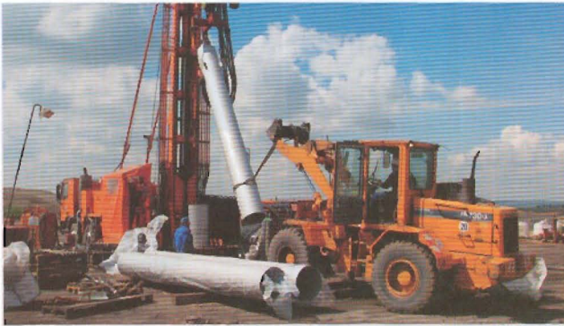
Abb. 3 Ausbaurbeiten auf der Großbaustelle Ronneburg/Thüringen
