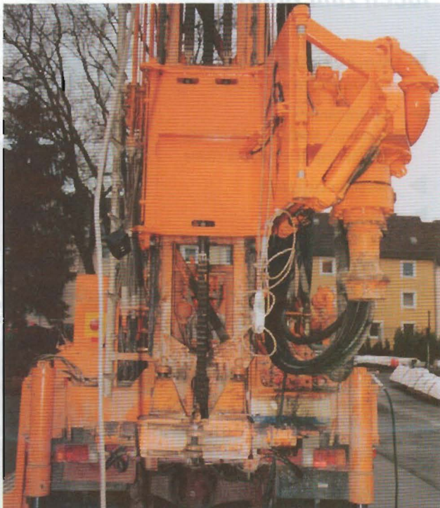
Abb. 6 Um die Bohrarbeiten größeren Umfangs leisten zu können, wurde das Bohrgerät vom Typ UH3 mit einem verstärkten Kraftdrehkopf ausgestattet.
